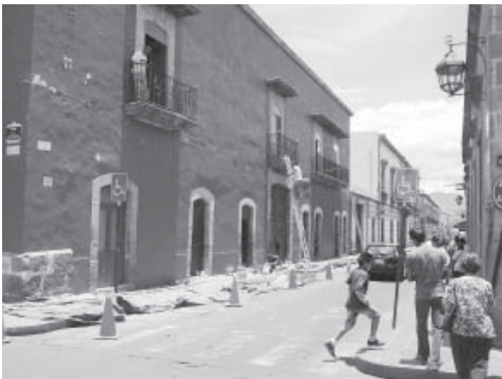
La casona de Morelos Norte y Aquiles Serdán en plena restauración de 14 millones de pesos. (Foto: Isauro Gutiérrez)
